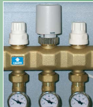
Toimilaitte kierretään valkoisten paluuventtiileiden hattujen tilalle.
